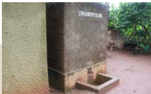
Installation von Wassertanks direkt an den Häusern, um Trinkwasser zu sichern
