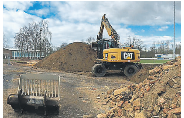
Von der alten Tribüne ist nicht mehr viel übrig. Mit dem Abriss hat der zweite Bauabschnitt bei der Umgestaltung des Stadions im Trier begonnen.
