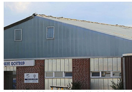
Das alte Dach der Tennishalle war nicht nur undicht, es enthielt auch Asbest. Jetzt werden die rund 2000 Quadratmeter mit Aluminiumelementen eingedeckt.
